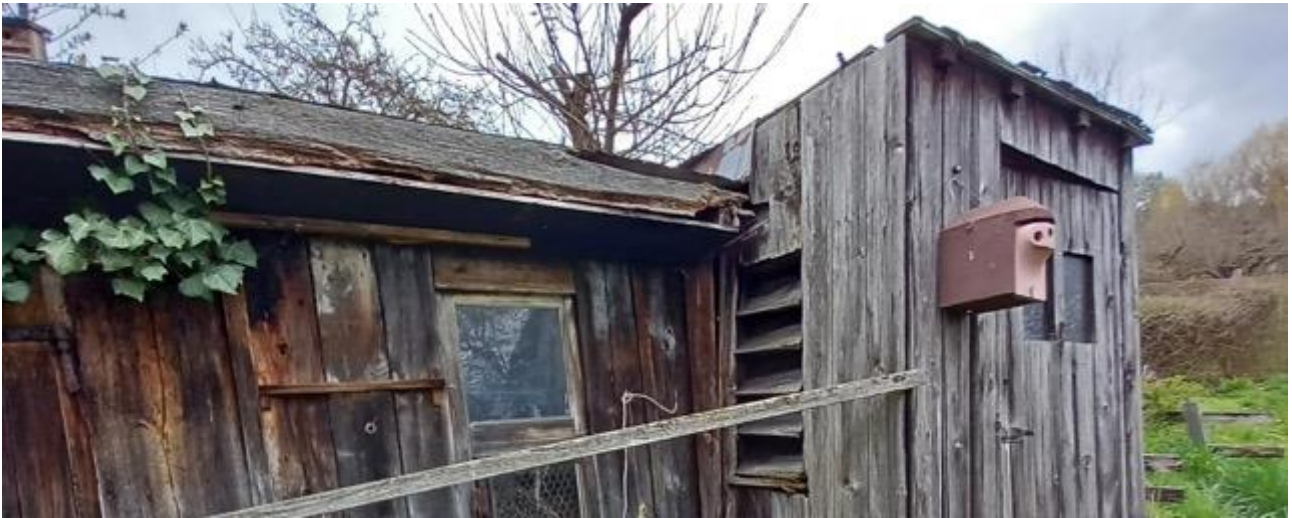
Abbildung 4: Holzhütte im südlichsten Flurstück 719, Blick nach Nordosten; Foto: R. Fischer
