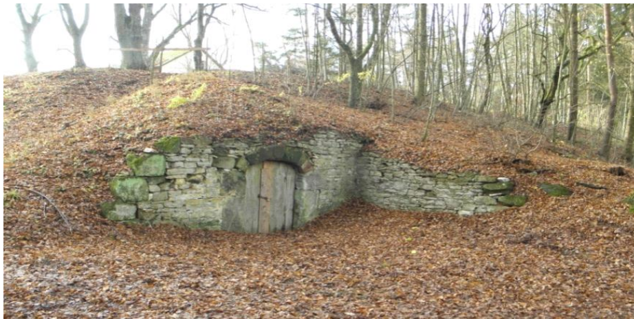
Neuzeitlicher, nördlicher Bierkellereingang
