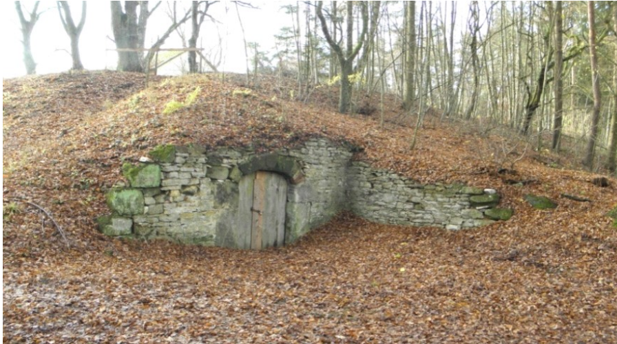
Neuzeitlicher, nördlicher Bierkellereingang
