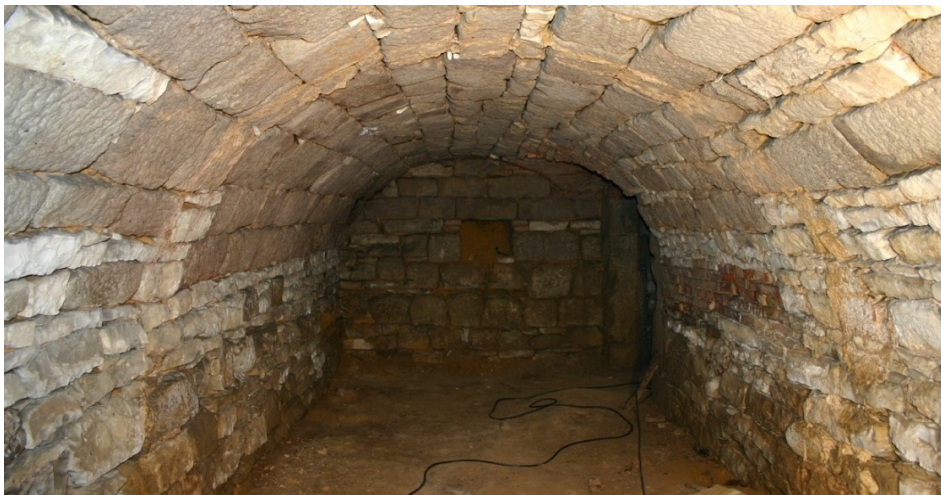
Vorkeller , hinten rechts ist der Eingang in den Hauptkeller
