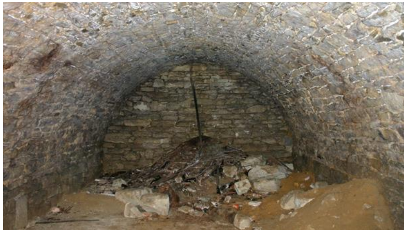
Gewölbe des Hauptkellers
